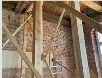
Mauerwerk vorbereitet für Bohrlochinjektion im
